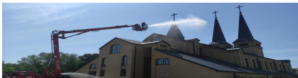
Podawanie prądu wody na dach kościoła
