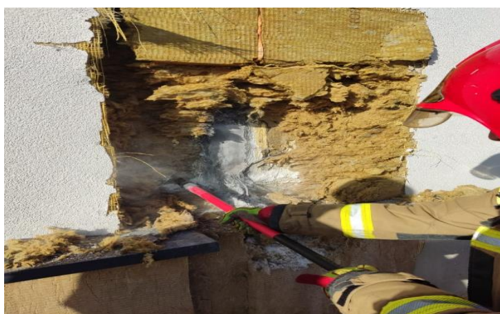
Widok ratowników podczas odrywania ocieplenia elewacji
